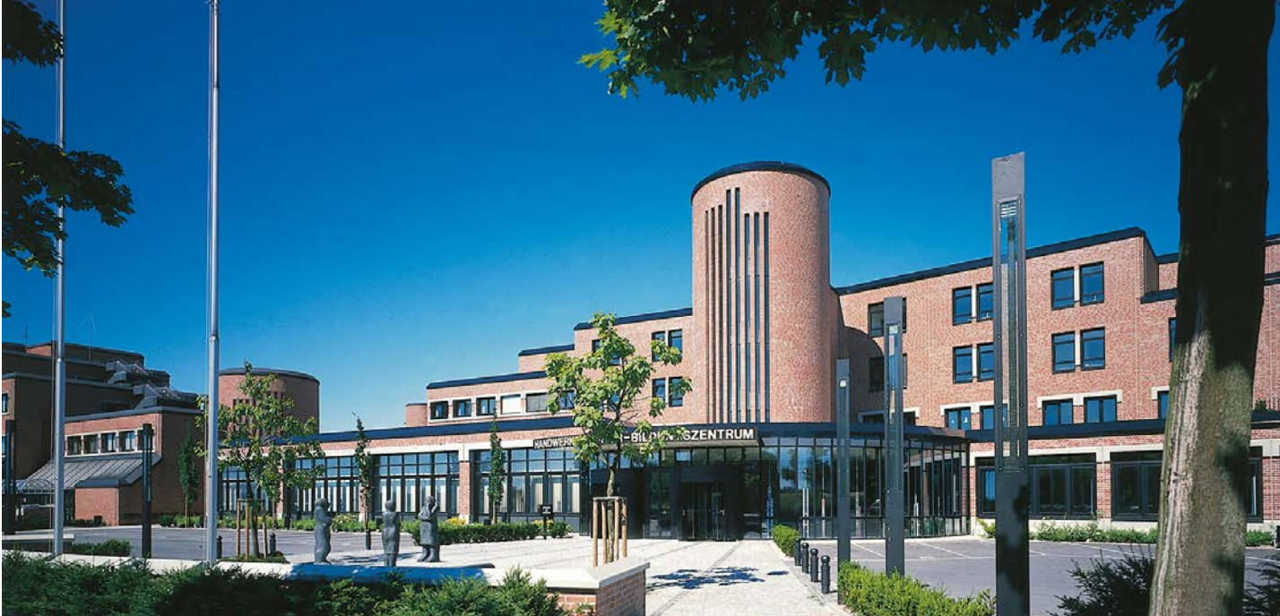
In die Jahre gekommen: Der erste Gebäudeteil des Handwerkskammer Bildungszentrums wurde 1978 errichtet. Es besteht Modernisierungsbedarf.
