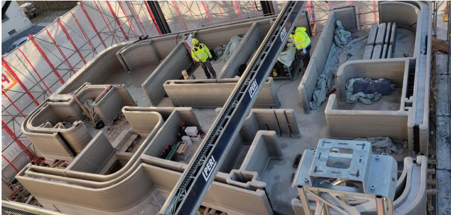
Ein Computerprogramm steuert den Drucker nach einem 3D-Modell des späteren Hauses. Aussparungen für Fenster, Türen, Kabel und Rohre sind einprogrammiert. So wächst ein Haus gleichmäßig über den gesamten Grundriss von unten nach oben.
